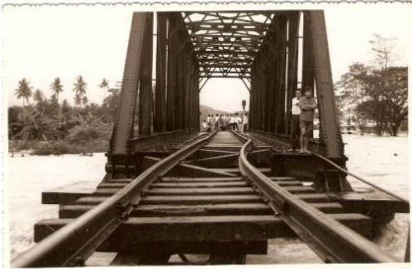
(7) Jambatan keretapi (binaan besi asal, kini konkrit) menyeberangi Sungai Langat, di belakang Arked Mara dan TNB Kajang. Kelihatan landasannya bengkok akibat arus deras.
